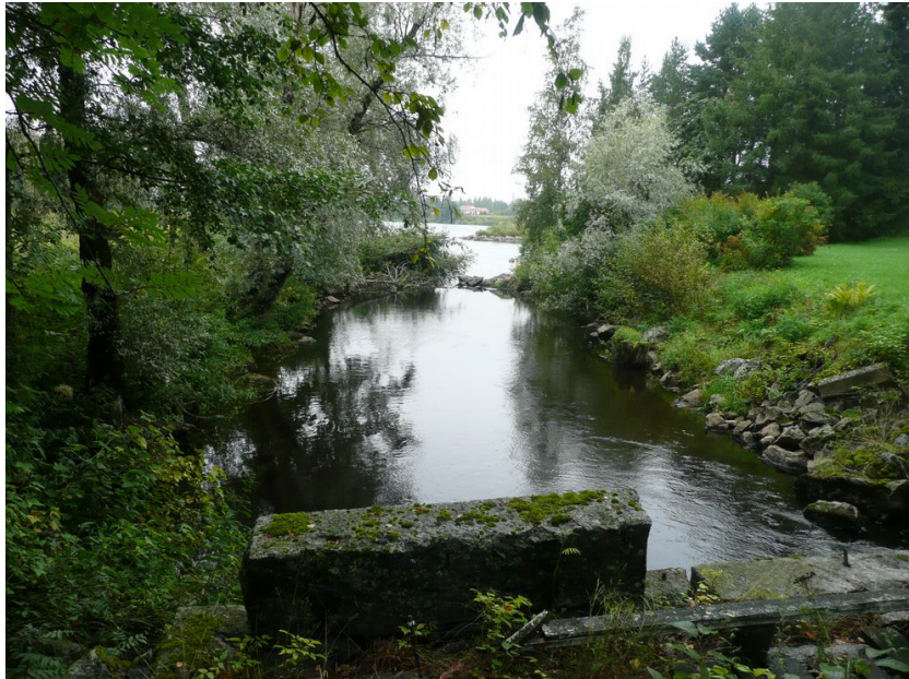
Kuva 25. Myllynuomaa ja pato t. ränni myllynpaikasta pohjoiseen.
