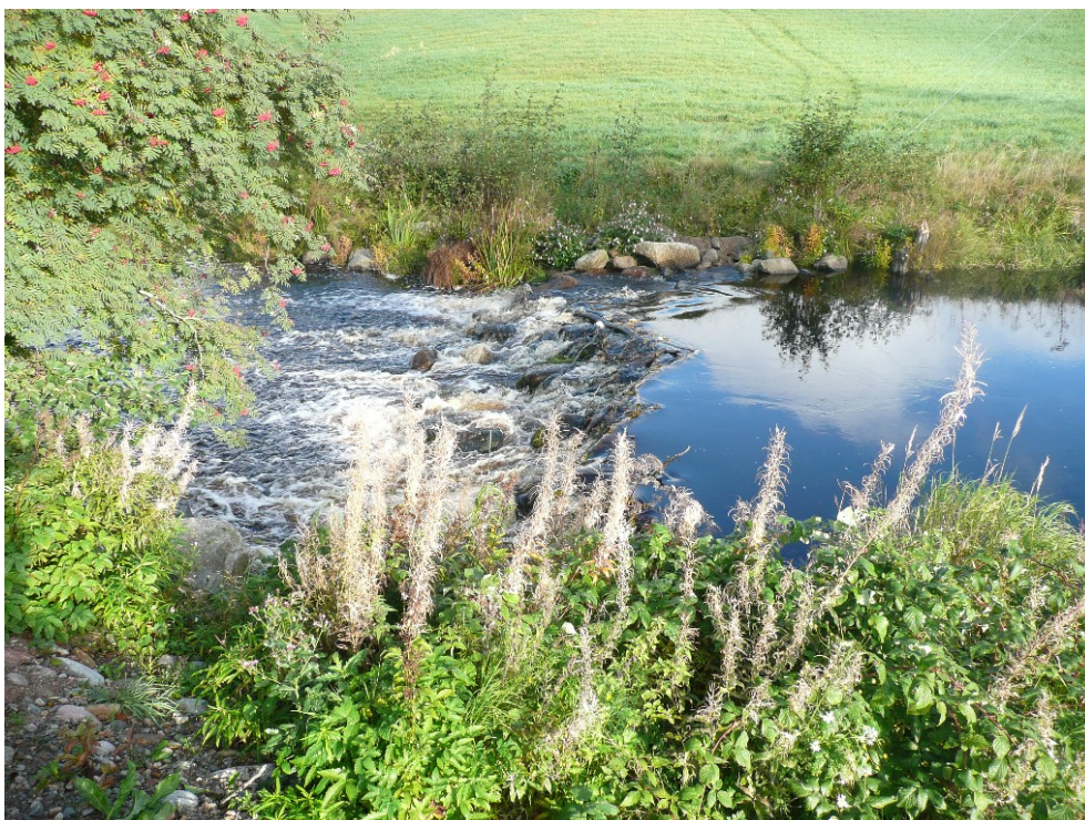
Kuva 7. Jyräsen kohteen kunnostettu pato kuvattuna joen etelärannalta.
