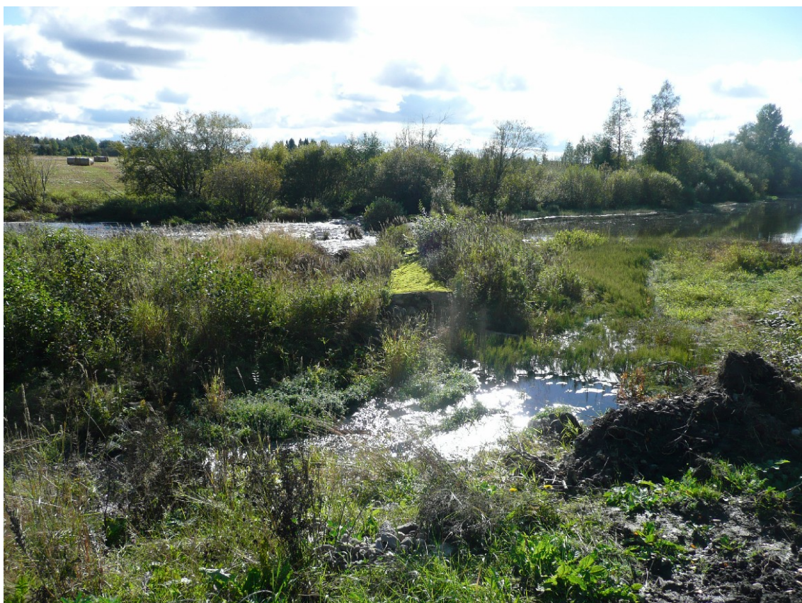
Kuva 14. Turjankosken pato kuvattuna pohjoisesta.
