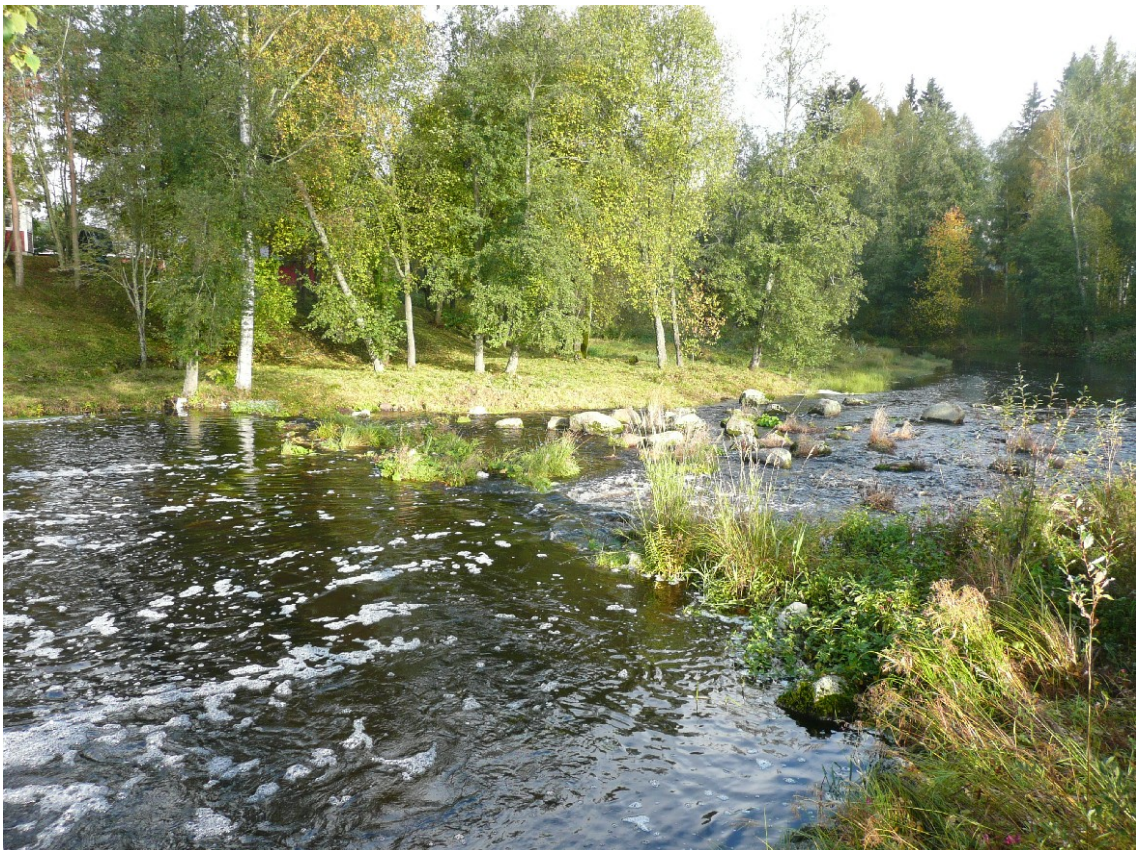
Kuva 10. Kosken kohteen hajonnut kivipato. Kuva kaakosta.
