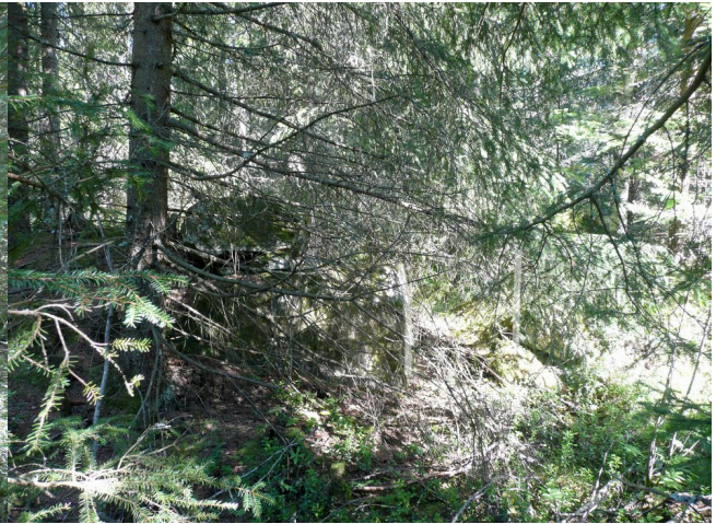
Kuva 3. Oviaukko kellarin perustuksen eteläsivulla.
