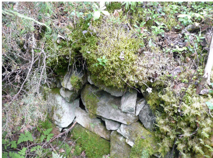
Kuva 8. Kellarikuopan seinämän kylmämuurausta.
