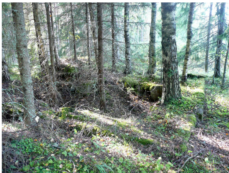
Kuva 9. Rakennuksen perustus tielinjauksen varrella.
