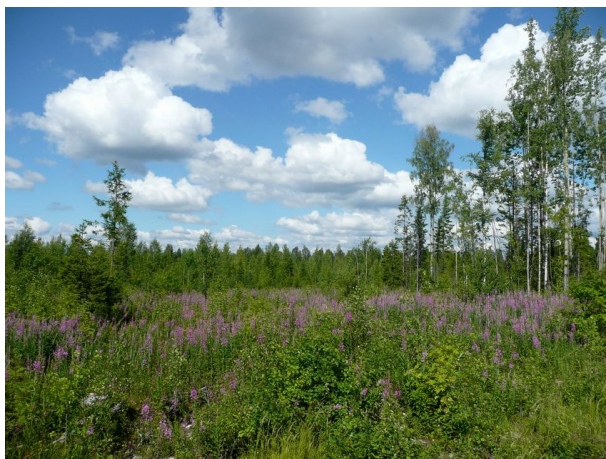
Kuva 13. Voimajohtolinjaus B Lankkunevan eteläpuolella kuvattu länteen.
