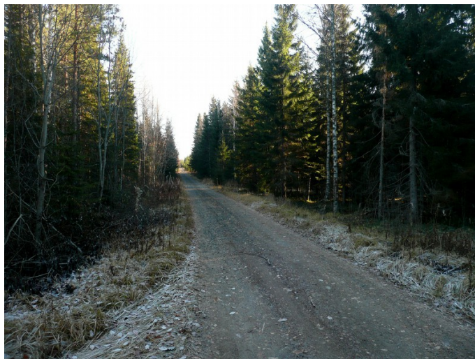
Kuva 9. Kunnostettu metsätie Aittanevan kohdalla kuvattu kaakkoon.
