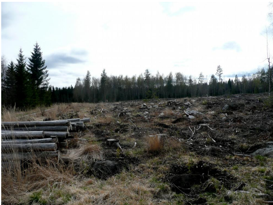
Kuva 27. Voimajohtolinjaus Tervajoelta lounaaseen.
