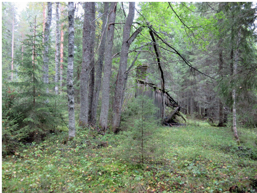
Romahtanut rakennus metsätien itäpuolella.
