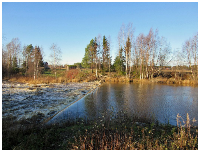
Kuva 9. Almängsfors Närpiönjoessa Finbyssä. Kuvassa vuonna 1978 valmistunut pato. Kuvattu luoteeseen. Kaapelireitti ylittää joen kohteen länsipuolella. Noin 100 itään oli toiminnassa sahamylly 1700-luvulla. Ilmeisesti paikalla on ollut mylly- ja/tai sahatoimintaa myöhemminkin.
