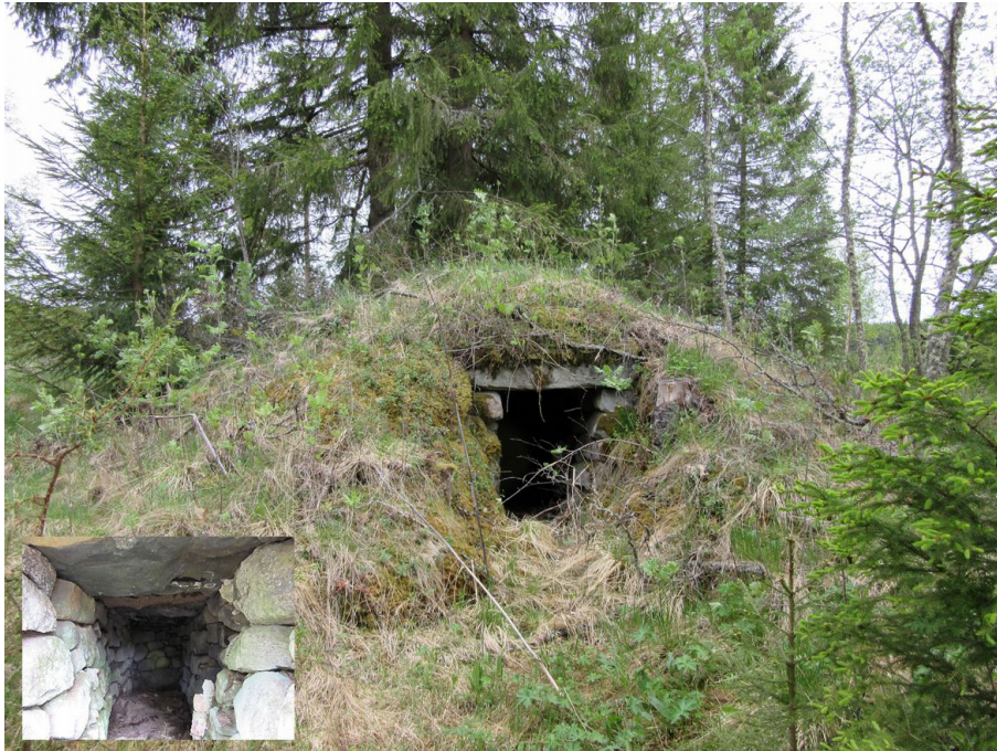
Rakenne 3, luonnonkivistä tehty kellari ja kuva sisältä.
