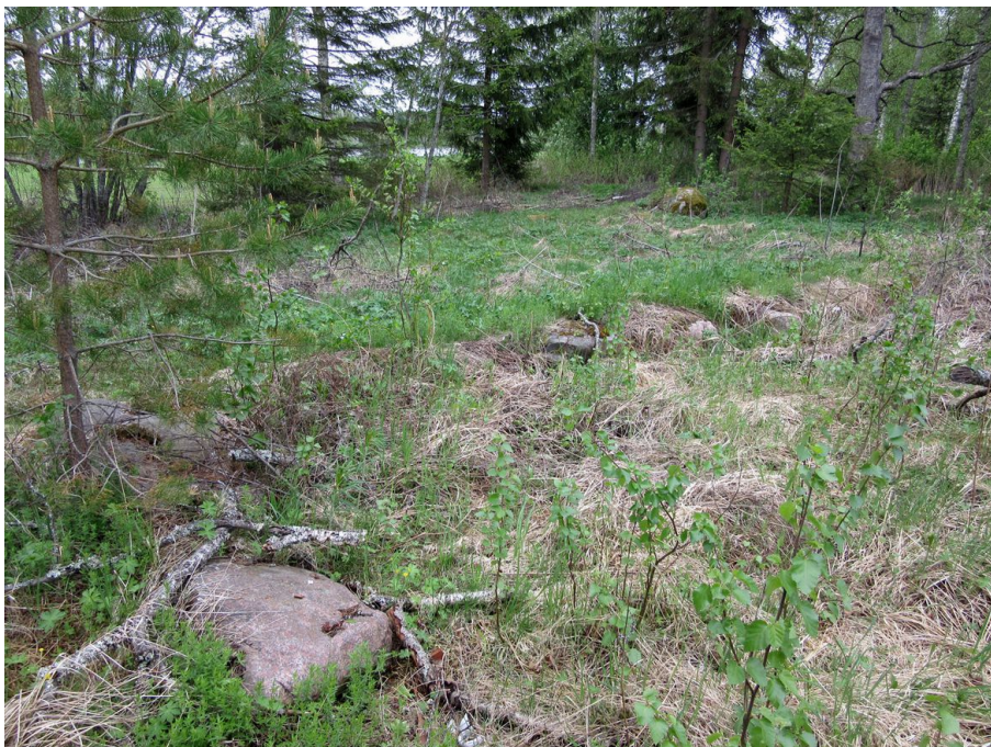
Rakenne 1, rakennuksen luonnonkivistä koostuvaa perustusta.
