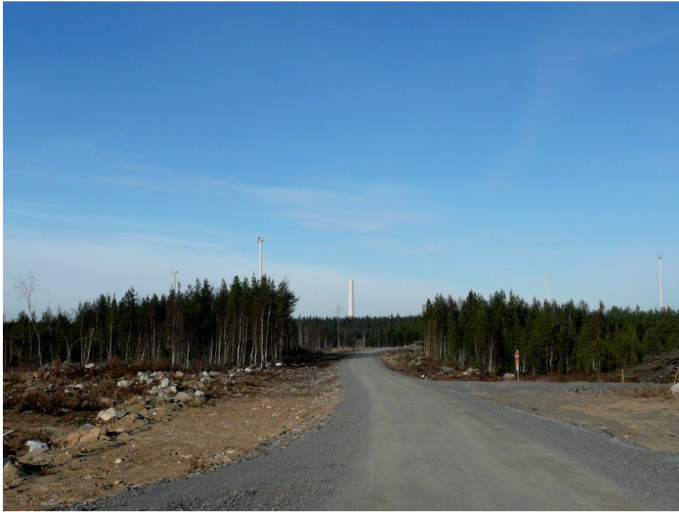
Kuva 4. Parannettu Romuperäntie kuvattu luoteeseen.
