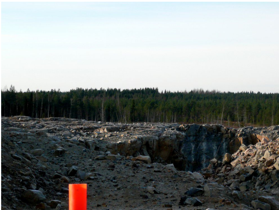
Kuva 3. Kalliolouhos Tupukankaan pohjoisosassa, kuvattu länteen.
