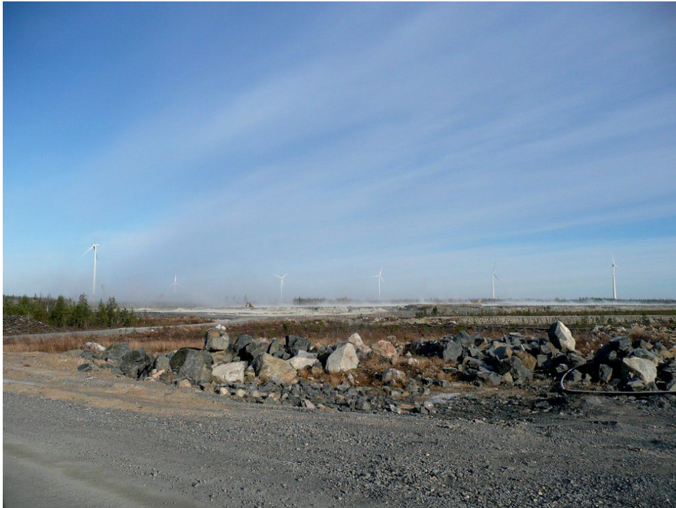
Kuva 2. Laivakankaan läjitysalue, taustalla tuulipuisto Kopsa II:n rakennustyömaa. Maapinta on kokonaan muokattu. Kuvattu koilliseen.
