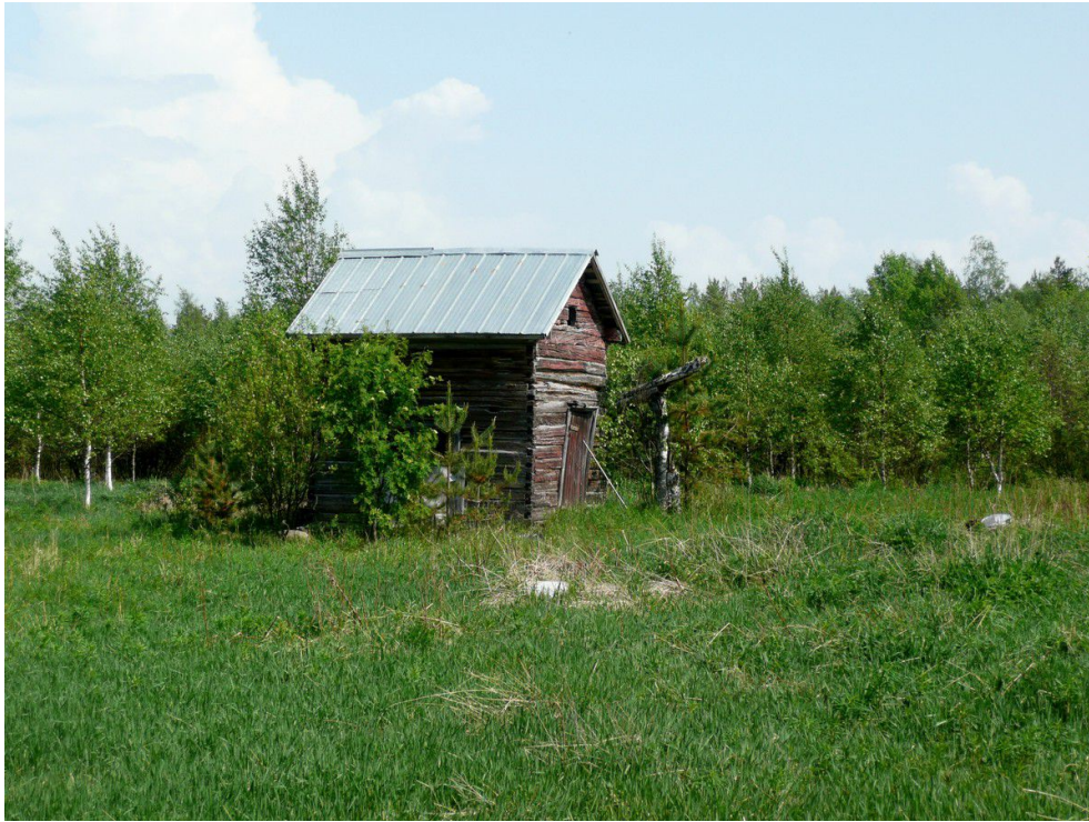
Pihapiirissä oleva vanha aitta kuvattu koilliseen.
