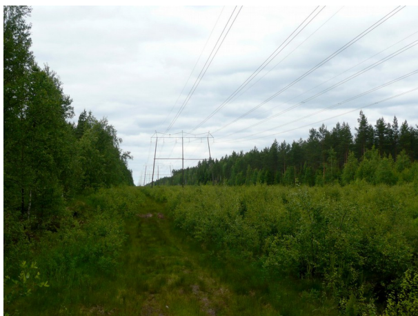
Kuva 10, nykyinen voimalinja Raudasnevan luoteispuolella kuvattu luoteeseen.
