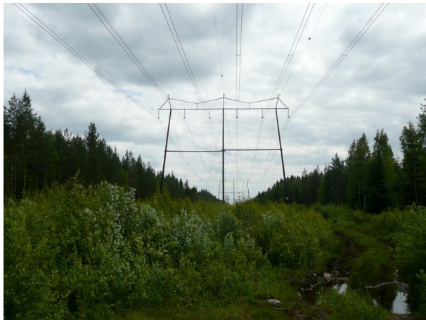
Kuva 9, nykyinen voimalinja Rahkarämeen kohdalla kuvattu kaakkoon.
