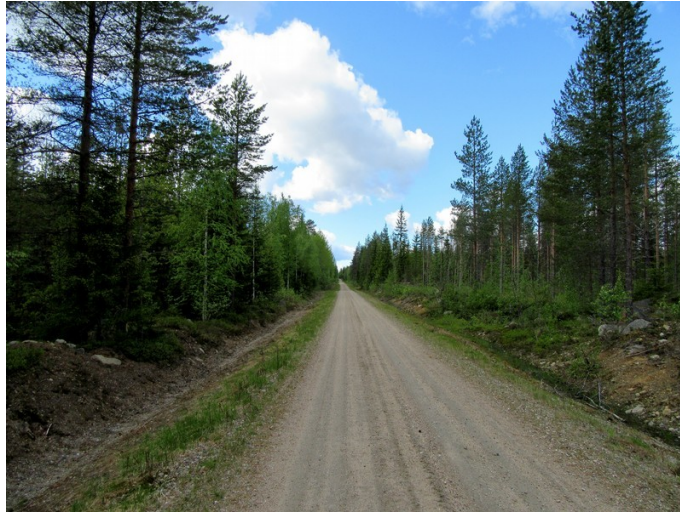
Kuva 19. Sähkösiirron pohjoinen haara Ollinvaaran kohdalla kuvattu länteen.
