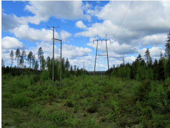
Kuva 22. Linjaus Seitenoikean sähköaseman itäpuolella; kivinen mäki, paikoitellen kalliota, kuvattu länteen.
