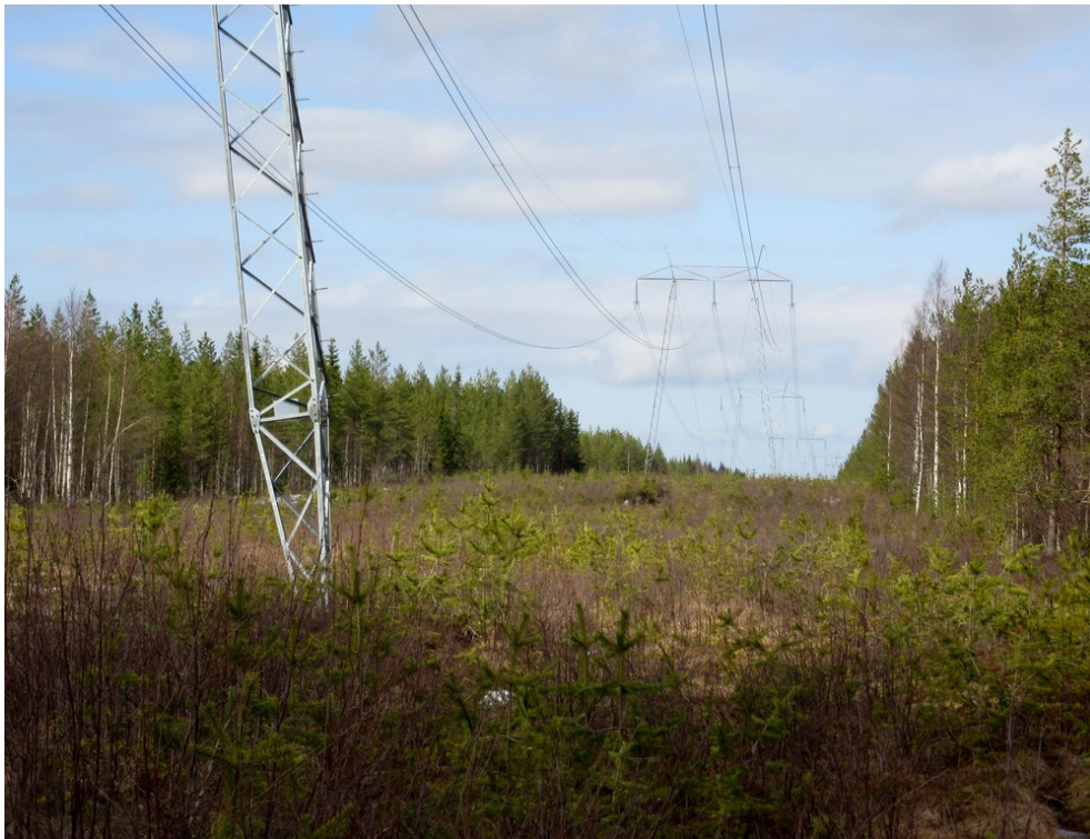
Kuva 10. Voimalinja hankealueen pohjoispuolella, kuvattu luoteeseen.
