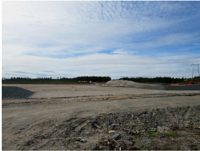
Kuva J. Isokankaan energiahuoltoalueen työmaa kuvattuna etelään.
