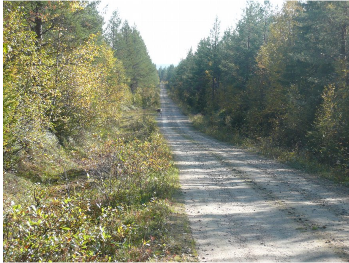
Kuva 16. Hankealueella oleva tie kuvattuna kaakkoon.
