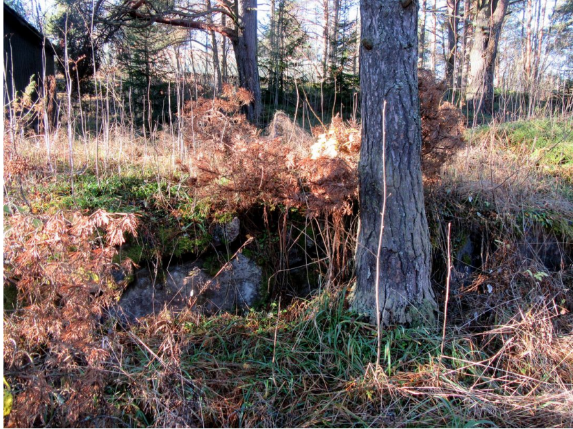
Perustuksen kylmämuurausta länteen.
