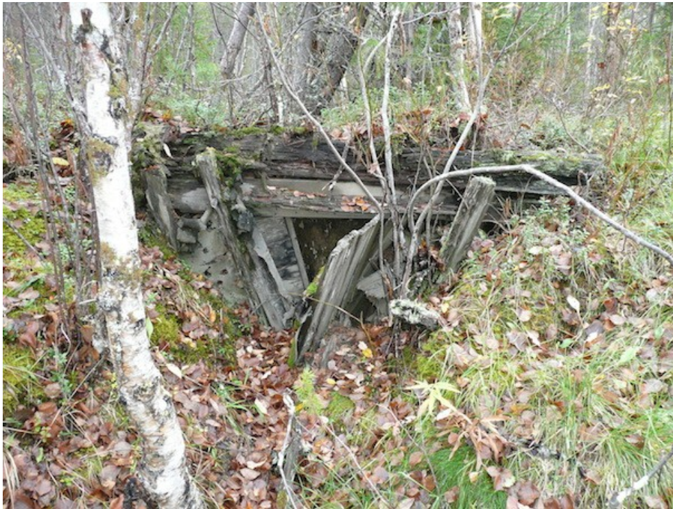
Lähikuva kellarin oviaukosta. Kuvattu itään.
