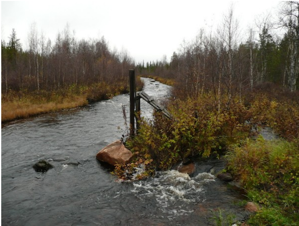
Itärannalla on jäljellä enemmän sillanrakenteita. Kuvattu pohjoiseen.
