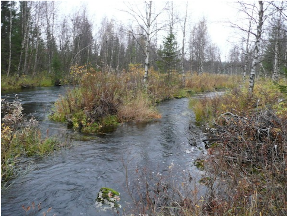
Kiviohjeseinän molemmin puolin virtaa vettä. Ohjeseinään on tehty parin metrin aukkoja joen edellisen ennallistuksen yhteydessä. Kuvattu länsiluoteeseen.
