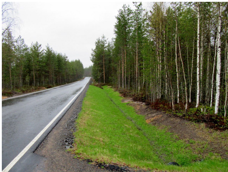
Mattilanperäntie kulkee asuinpaikan läpi. Tien pohjoisreunaa asuinpaikan kohdalla, kuva luoteeseen.
