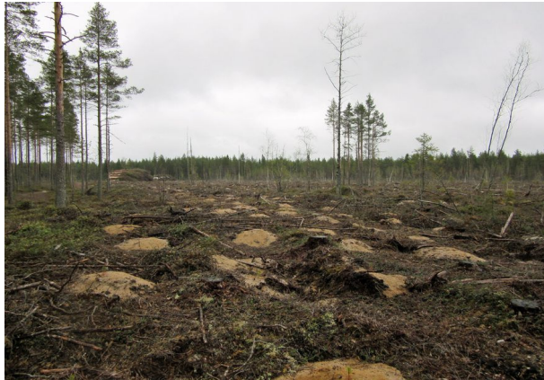
Suunniteltua vesijohtolinjausta Piehingin Ylipäässä Hautahaankankaan eteläpuolella, kuva koilliseen.
