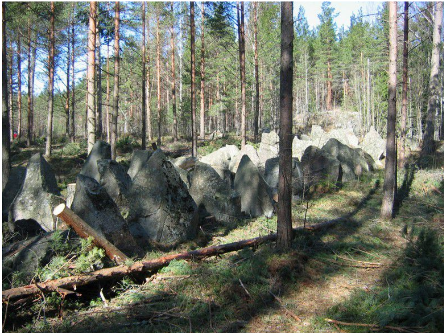
Kuva 5. Kivistä rakennettu panssarieste tien eteläpuolelta. Kuvattu lounaaseen.
