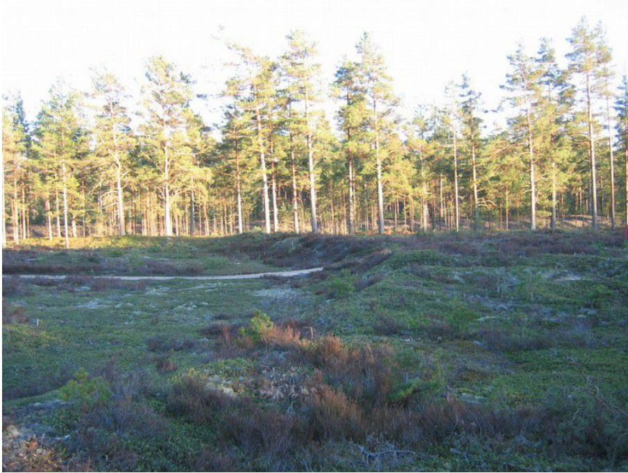
Kuva 19. Kaivanto voimalinjan alla. Kuvattu etelään.
