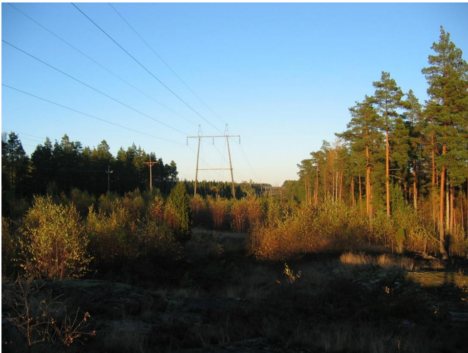
Kuva 6. Linjaa kohti pylvästä 11. Koilliseen.
