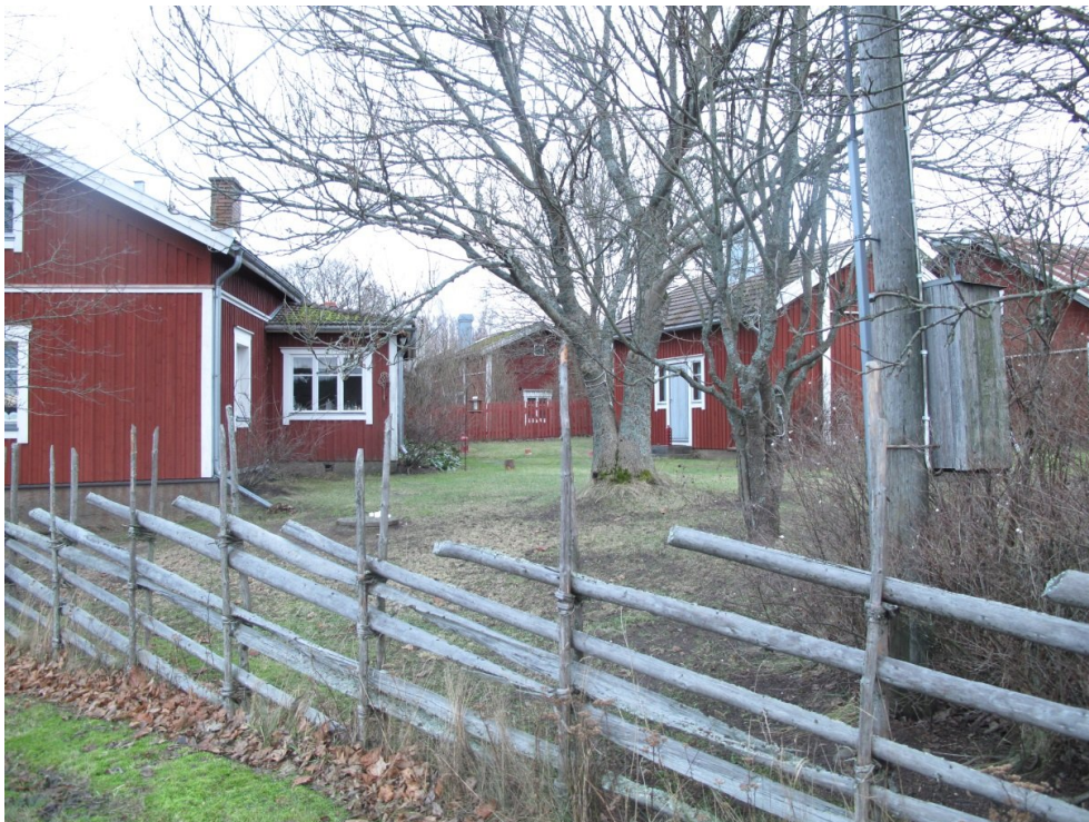
Kuva 26. Munittulan tontti on nykyisin varsin tiiviisti rakennettu, vanhempia rakenteita voi silti edelleen olla jäljellä. Pohjoiskoilliseen.
