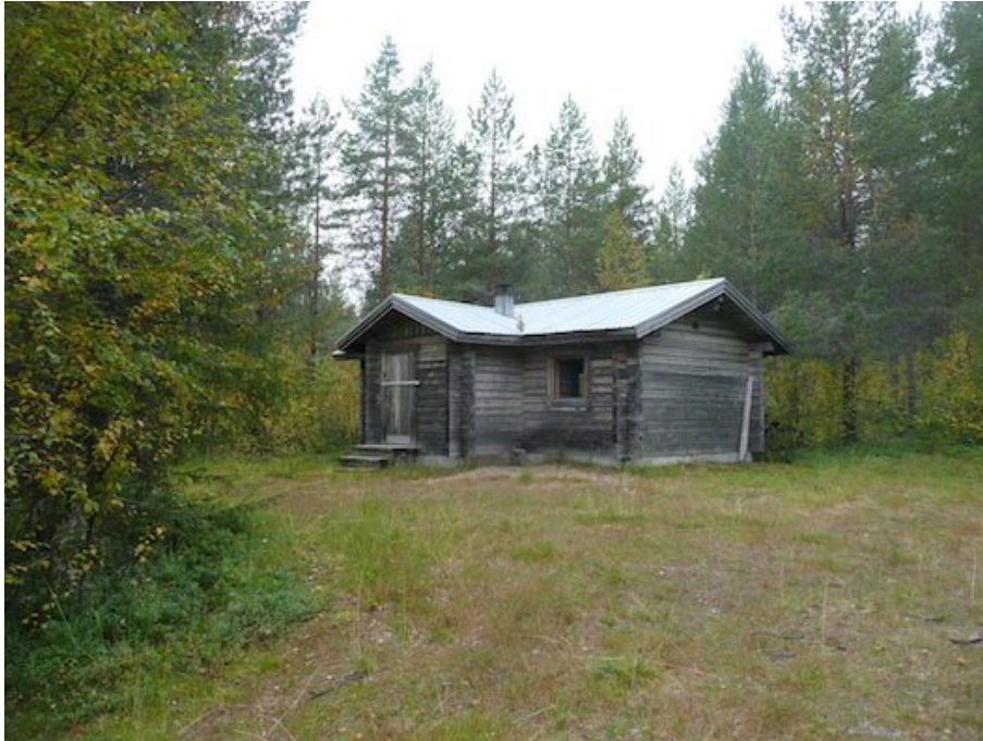
Kämppä kuvattuna koillisesta.
