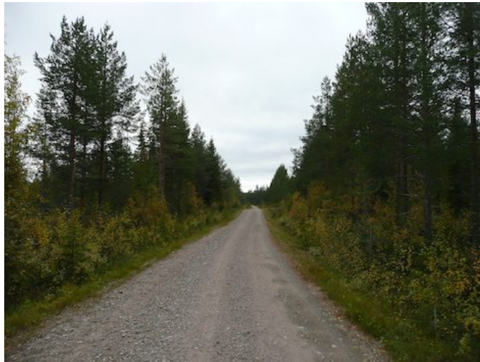
Kuva 14. Parannettava tie. Kuvattu etelälounaaseen
