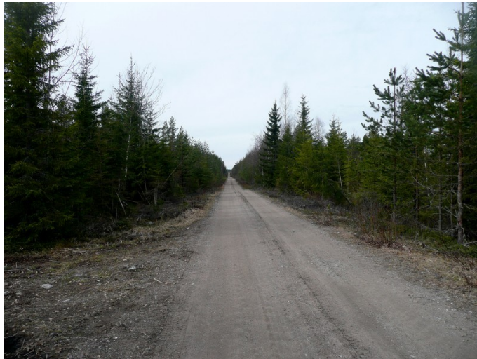
Kuva 4. Lehtolantie voimalapaikan A lounaispuolella, Kuvattu lounaaseen.
