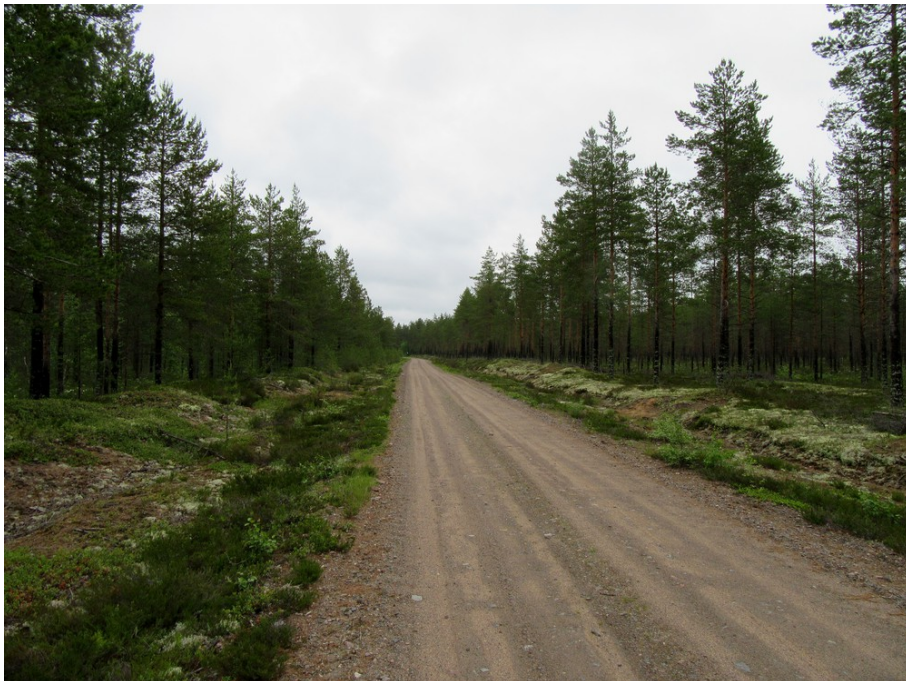
Kuva 4. Parannettava huoltotie voimaloiden 25 ja 24 pohjoispuolella. Tie kulkee matalalla kaarrolla, kuvattu itäkoilliseen.
