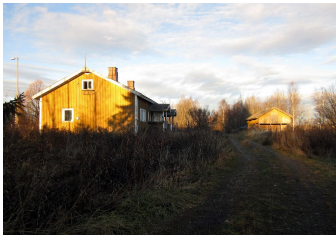
Entisiä asemarakennuksia. Kuva koilliseen.
