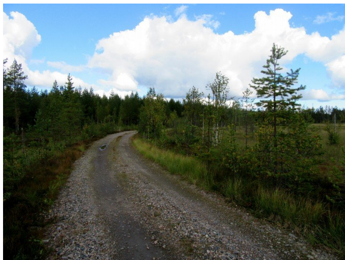
Kuva 9. Tielinjaus Kuivauslammen lounaispuolella kuvattuna pohjoiseen.
