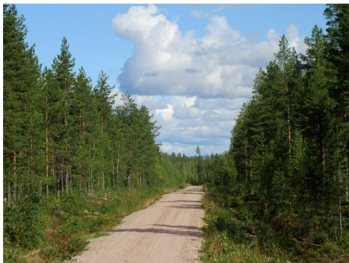
Kuva 30. Tielinjaus hankealueen pohjoisosassa kuvattu koilliseen.
