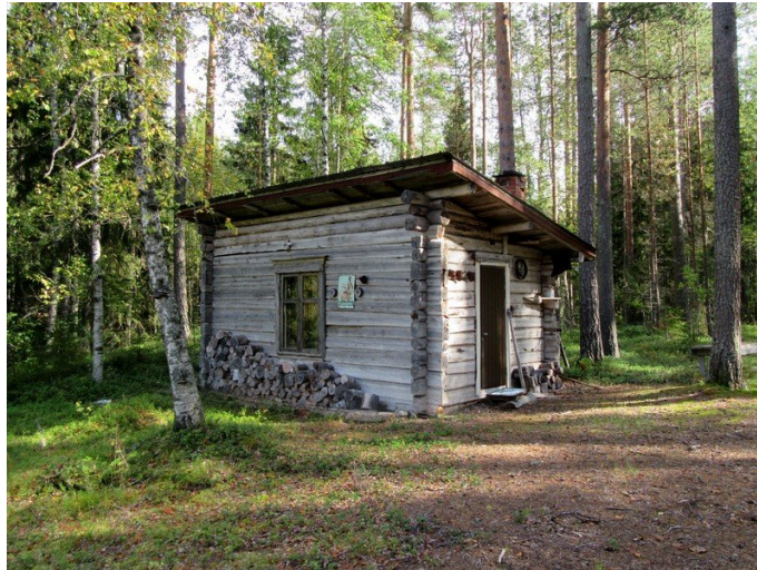
Kuva 25. Vanha työkämpä hankealueen pohjoisosassa, nykyään ilmeisesti vapaa-ajan/metsästyskäytössä.
