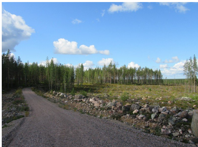
Kuva 33. Voimalapaikka T26 ja uusi tielinjaus kuvattu länteen. Kivinen kuivahko kangas, laajalti avohakattu ja muokattu.
