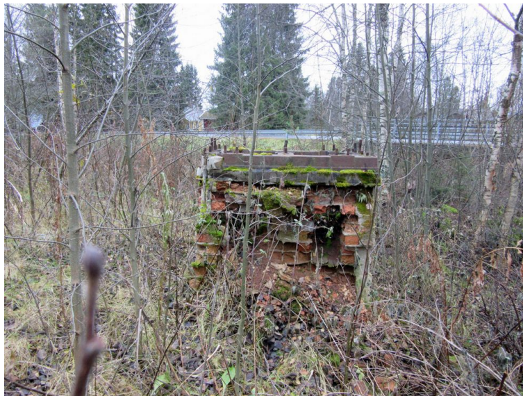
Saha- ja myllylaitokseen liittyneen rakennuksen hormin jäänteet.
