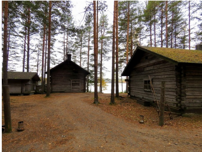
Kuva 7. Vanhoja siirrettyjä rakennuksia (Piispalan talon piha-rakennuksia ?) leirintäalueen lounaisosassa, kuvattu etelään.
