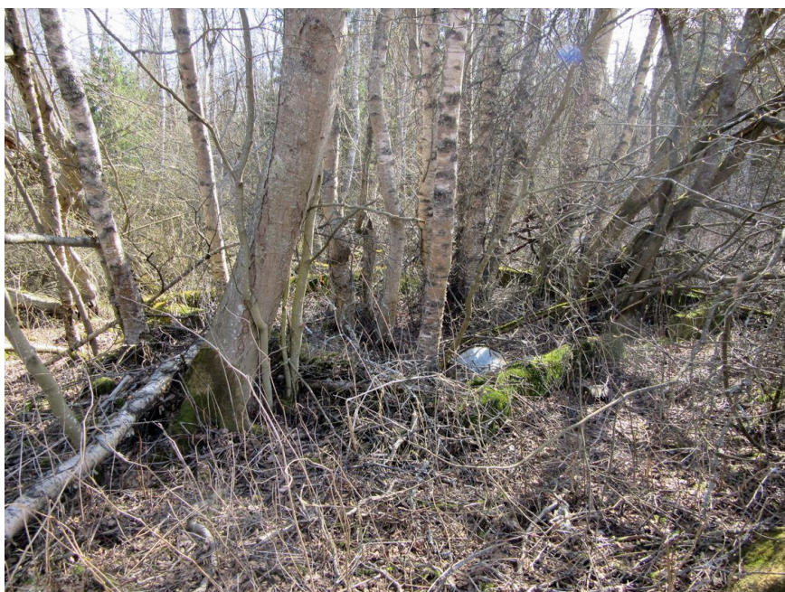
Rakennuksen betonikehikko kuvattu lounaaseen.
