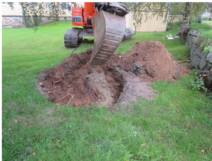
Kuva 1. Työt aloitetaan itäisestä porakaivosta, kuvattu länteen, taustalla vasemmalla kirkko, oikealla huoltorakennus.
