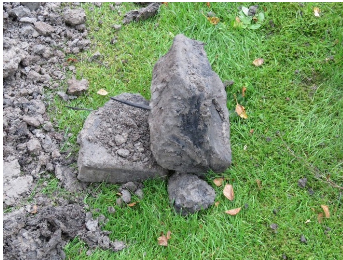
Kuva 11. Ukkosjohtimien ankkurit betonipaloissa.
