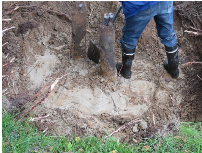
Kuva 2. Porakaivon putken kohta puhdistettiin lapiolla.
