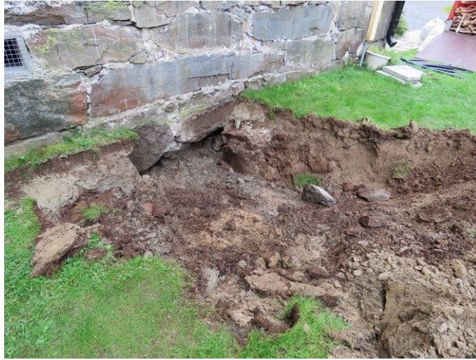
Siirtymäputken liittymiskohta kirkon seinän kohdalla. Täyttömaakerros seinän ulkopuolella koostuu hiekasta ja kivistä.
