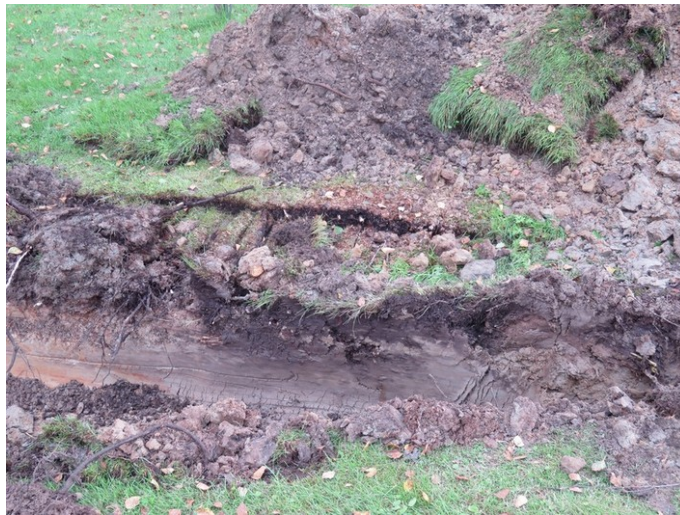
Kuva 3. Profiili kohdalla 4 – 7 m, kuvattu etelään.
