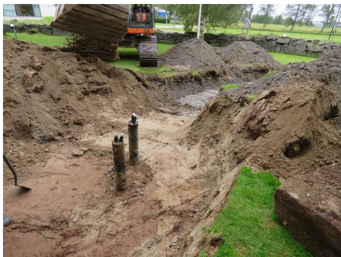
Kuva 14. Porakaivo kirkon seinän vieressä kuvattu luoteeseen.
