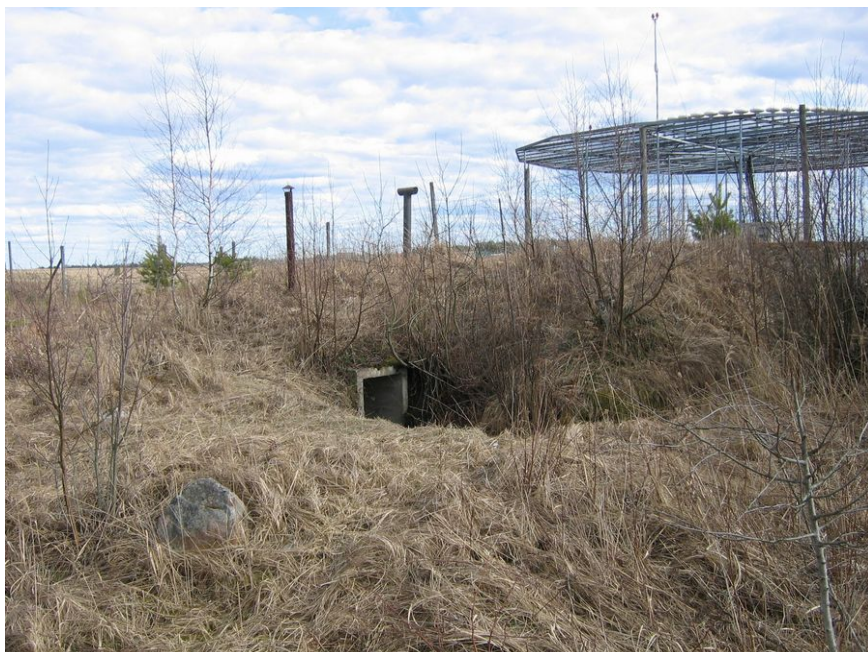
Kuva 22. Bunkkerin sisäänkäynti lentokentän pohjoispuolella.
