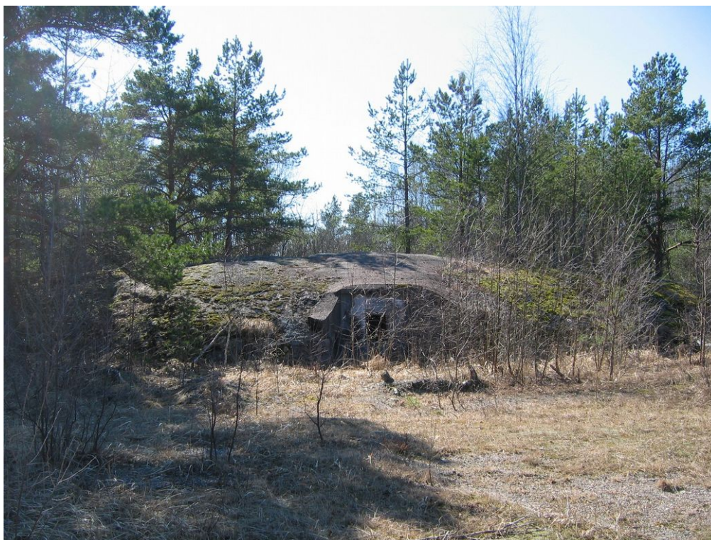
Kuva 16. Lentokentän eteläpuolella sijaitseva bunkkeri. Länteen.
