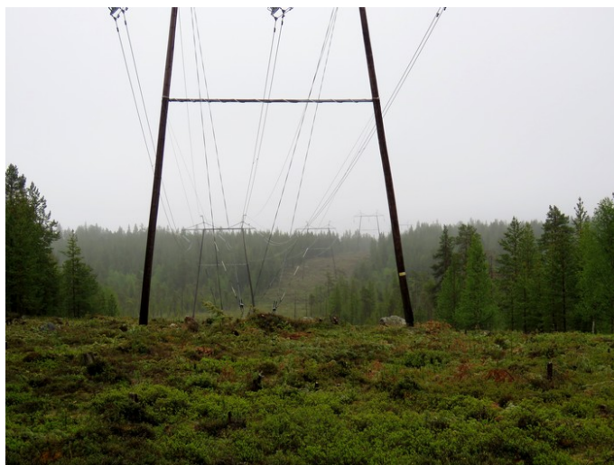
Kuva 4. Linjaus Latovaaran länsipuolella kuvattu lounaaseen.
