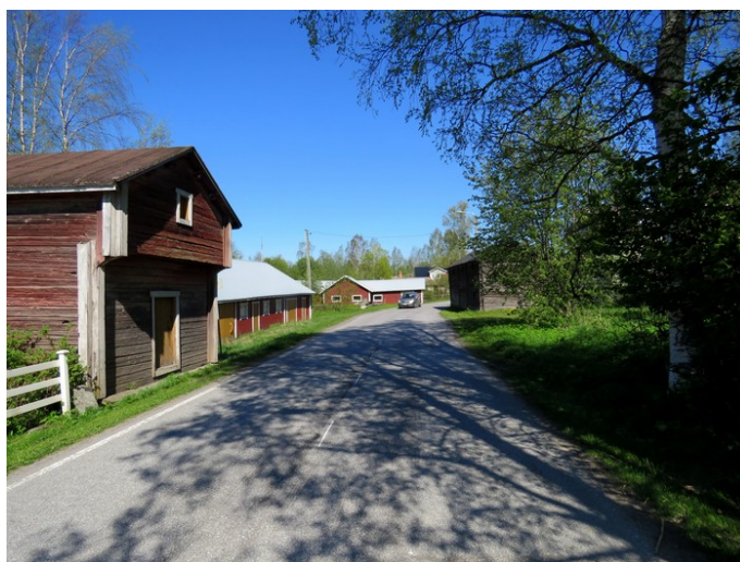
Kuva 3. Vanhaa rakennuskanta Sautinkarintien itäosassa.
