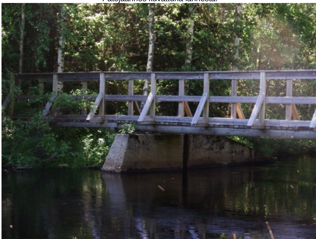
Patojäänöksen betonirakenteet ovat vielä ehjät. Kuvattu lounaasta.
