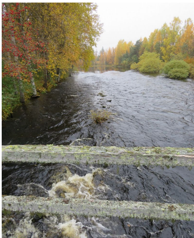
Suiste kuvattuna pohjoiseen Kuurtajan sillalta.
