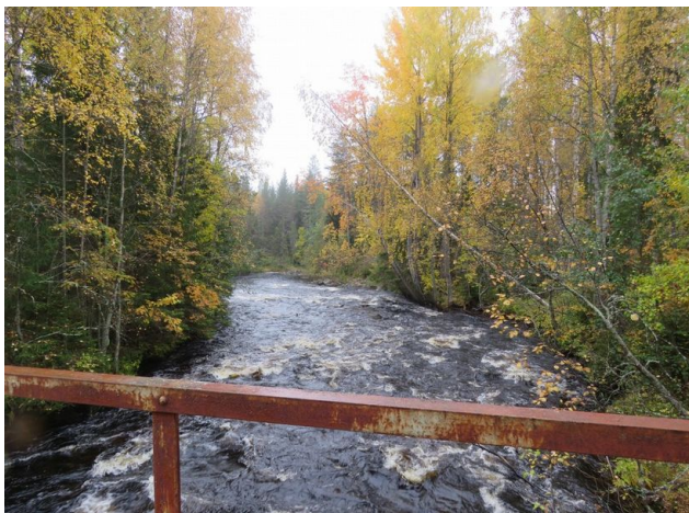
Kosken yläosaa kuvattuna vanhan tien sillalta etelään.
