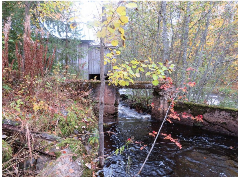
Padon juoksutusaukko etelään, taustalla myllyrakennus.
