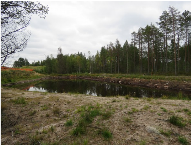
Uusi vesiallas alueen lounaispäässä.
