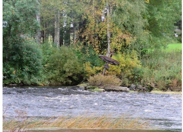
Myllyn koneistoa ja betoniperustusta joen itärannalla.
