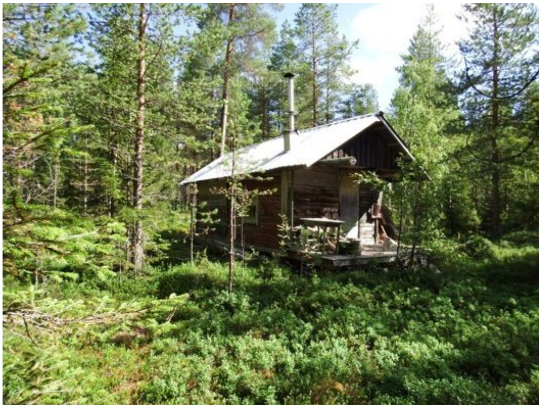
Rakennus kuvattuna lännestä.
