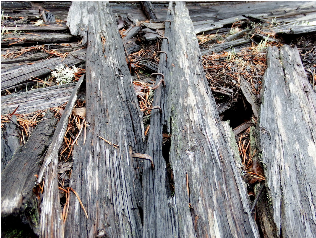
Kattorakenteissa olevia taottuja nauloja.
