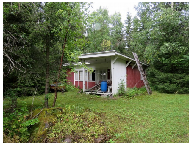
Kuva 18. Nro 122, pulpettikattoinen mökkirakennus.
