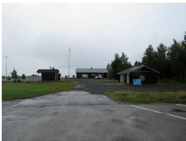
Kuva 11. Tornion veneseura Oy:n rakennuksia länteen.
