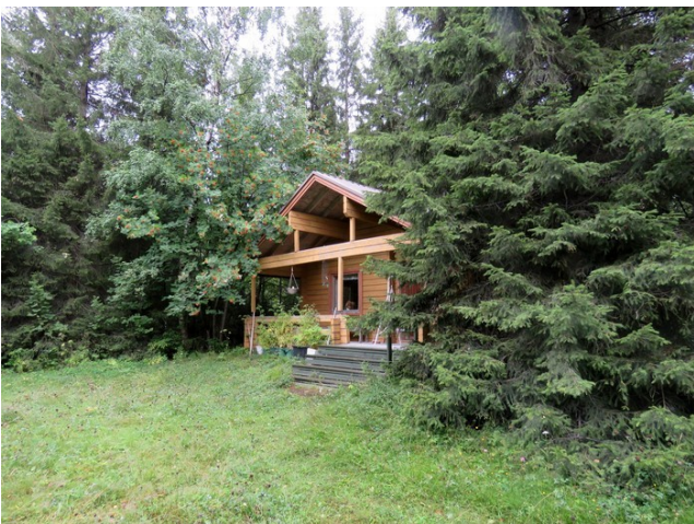
Kuva 13. Nro 141, uudempi hirsinen mökkirakennus.
