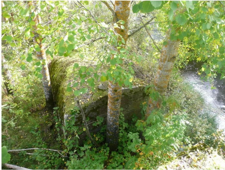
Kuva 34. Sillan kivijalka I. jäänsärkijä kuvattuna luoteesta.
