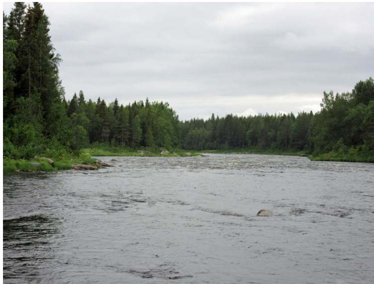
Kalliokosken itähaara, padon kohta lounaaseen.
